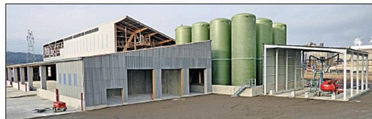
**Le stockage de Neuves-Maisons est dimensionné pour accueillir 3.900 t de solution liquide et 7.500 t d'engrais solide. Il permet d'ensacher 1.500 t à l'abri et 1.500 t en extérieur dans des bigs bags.**
